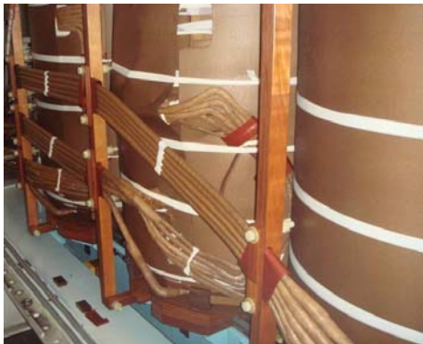
图1 变压器分接引线图
